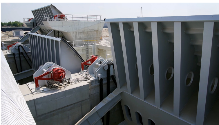
Napęd wrót jazu segmentowego silnikami Hägglunds, Węgry (Źródło obrazu: Bosch Rexroth)
