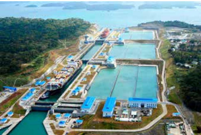
Schleuse des Panamakanals
